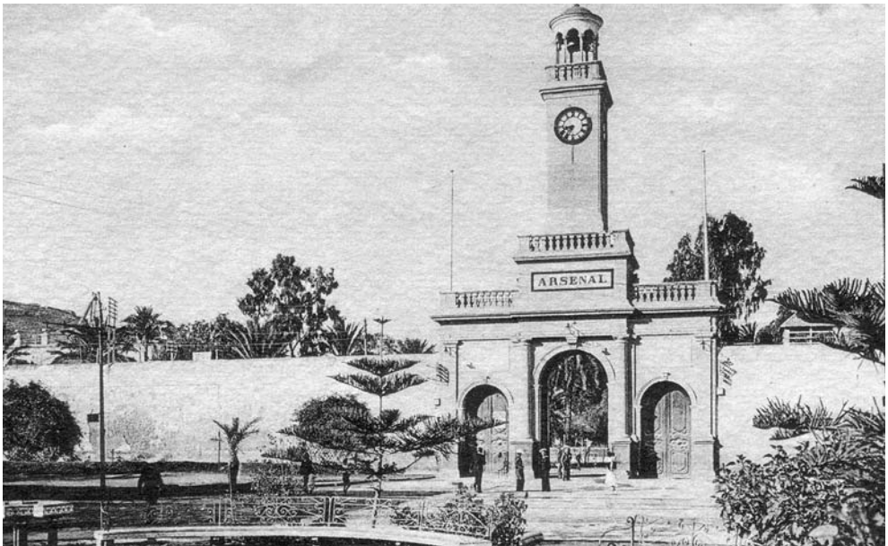
Puerta del Arsenal en las primeras décadas del siglo XX.
